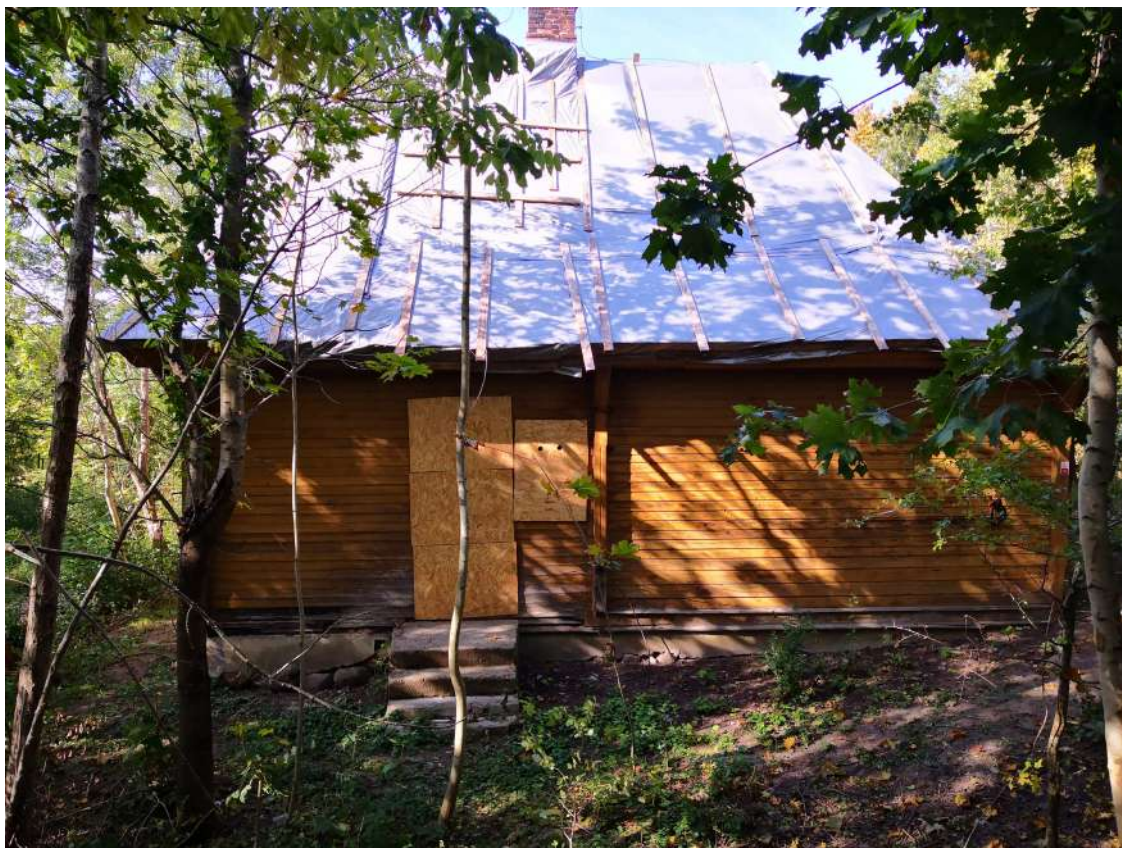
Fot. 4 Widok od strony południowo-wschodniej.
