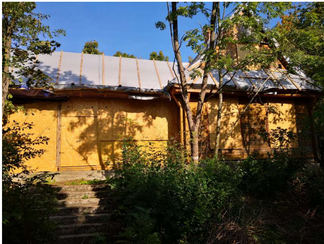
Fot. 2 Ściana frontowa (południowo-zachodnia) schroniska - prostopadły widok na werandę
