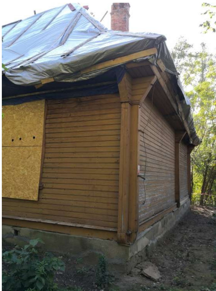
Fot. 5 Narożnik północny i ściana północno-zachodnia schroniska.
