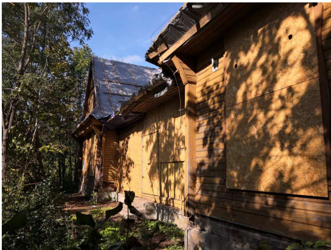
Fot. 1 Ściana frontowa (południowo-zachodnia) schroniska z naprawioną werandą.
