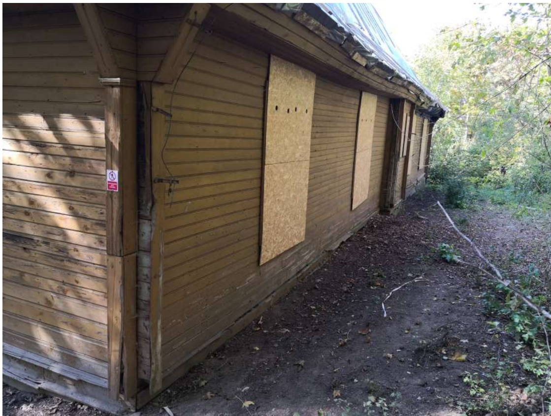
Fot. 3 Narożnik wschodni ściana północno-wschodnia schroniska.
