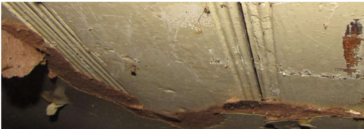
Fot. 31 Odkrywka na ścianie działowej poddasza między korytarzem i więźbą dachu o niewielkim spadku.
