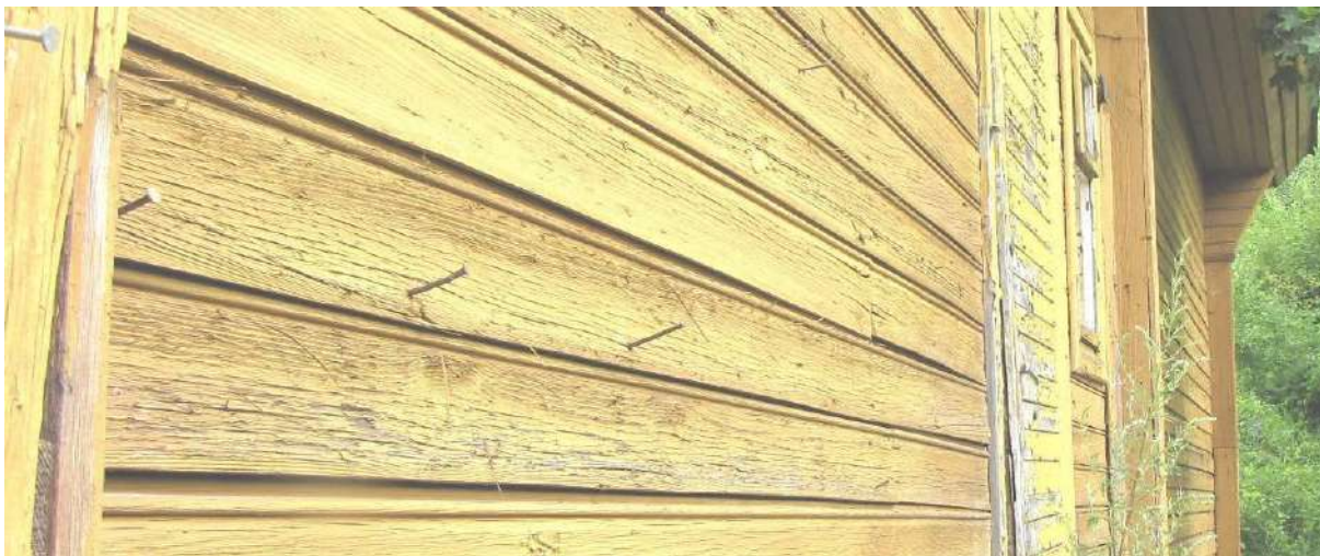
Fot. 25 Fragment elewacji południowo-zachodniej
