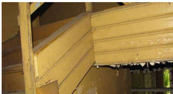
Fot. 29 Fragment klatki schodowej i osłony zakrywającej grubość stropu nad parterem.
