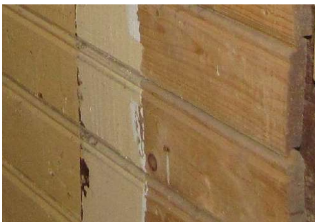
Fot. 26 Odkrywka ukazująca profile desek szalunkowych korytarza za dawnym piecem grzewczym.
