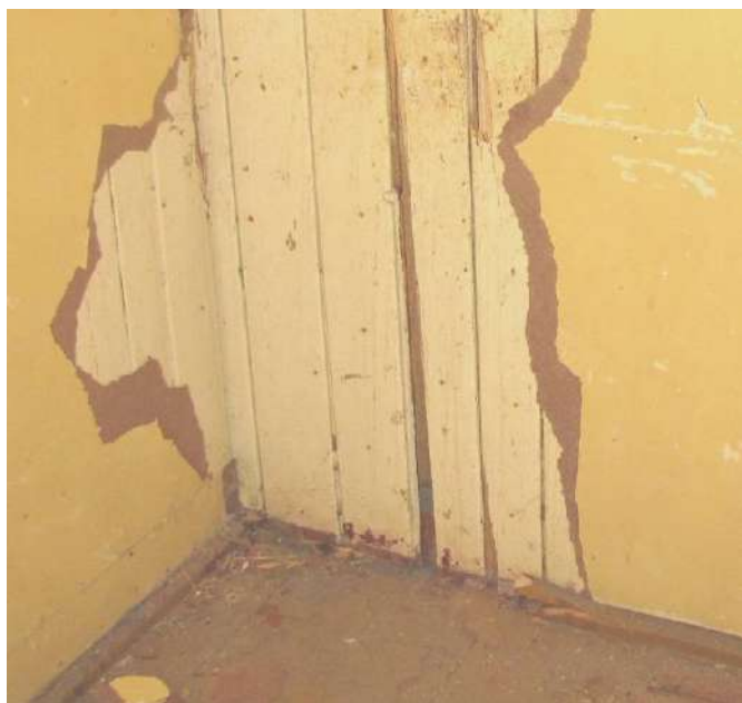
Fot. 23 Odkrywka konstrukcji ścianek poddasza. Deski szalunkowe przybite są gwoździami do poziomych łąt zamocowanych do desek podłogowych.
