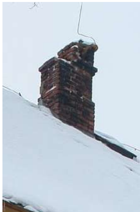
Fot . 15 Dzisiejszy stan komina w widoku od wschodniej połaci dachu.
