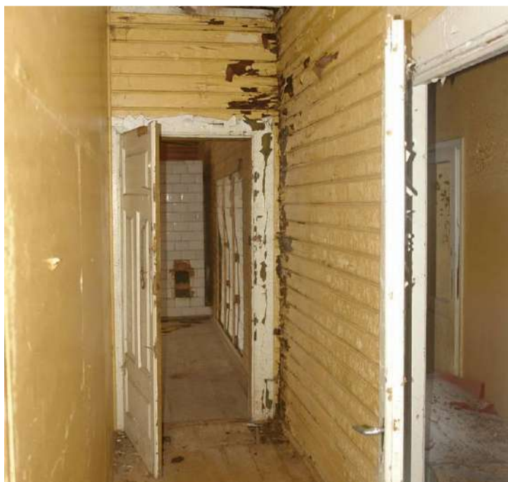
Fot . 17-19 Odkrywki przy badaniach materiałowych ścian działowych na parterze. Dwie pierwsze, na ściankach działowych pokoiów odsłoniły płytę wiórową. Trzecia fotografia pokazuje korytarze utworzone po podziałach wcześniejszych pomieszczeń budynku wzdłuż podłużnej ściany konstrukcyjnej – widok w kierunku d. jadalni.
