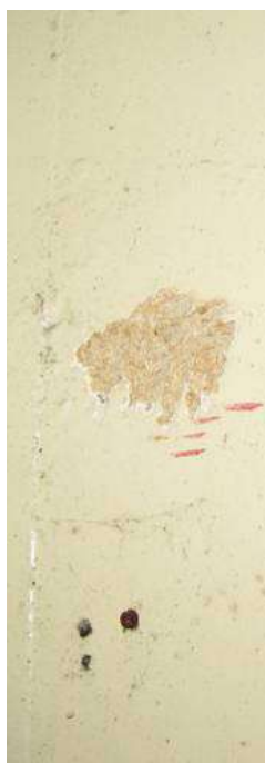
Fot . 17-19 Odkrywki przy badaniach materiałowych ścian działowych na parterze. Dwie pierwsze, na ściankach działowych pokoiów odsłoniły płytę wiórową. Trzecia fotografia pokazuje korytarze utworzone po podziałach wcześniejszych pomieszczeń budynku wzdłuż podłużnej ściany konstrukcyjnej – widok w kierunku d. jadalni.
