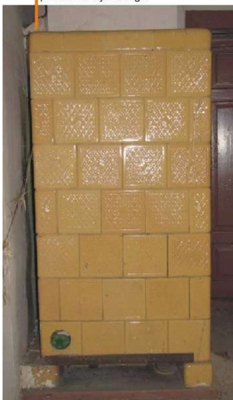
Fot . 8 Piec grzewczy w d. kuchni wymurowany w miejscu trzonu kuchennego.
