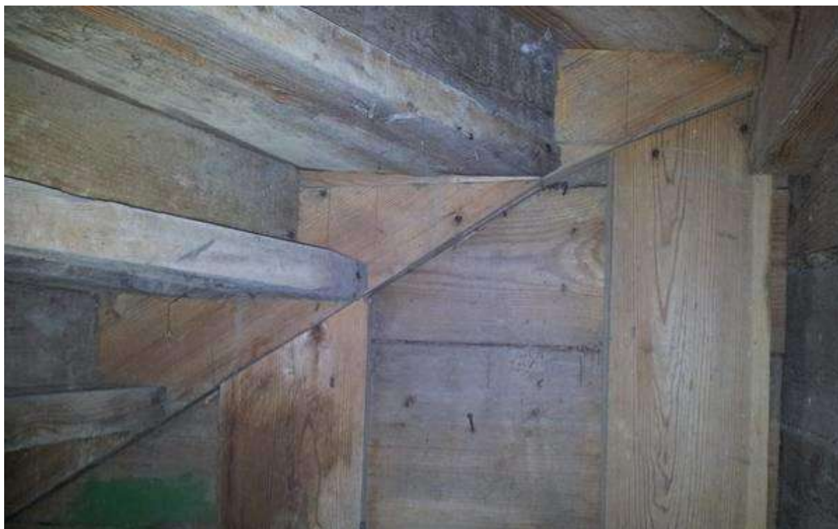
Fot. 38 Widok fragmentu konstrukcji schodów w narożniku ze schodami zabiegowymi.
