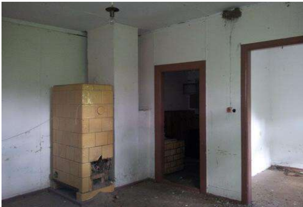
Fot. 12 Widok na północny narożnik d. kuchni przed odkrywkami z „nowym” piecem w miejscu dawnego trzonu kuchennego.
