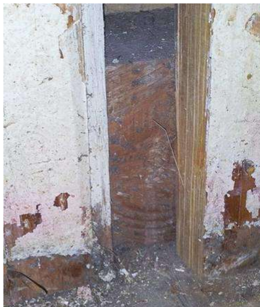
Fot. 24 Odkrywka konstrukcji ścianek poddasza. Detal z sąsiedniej fotografii.
