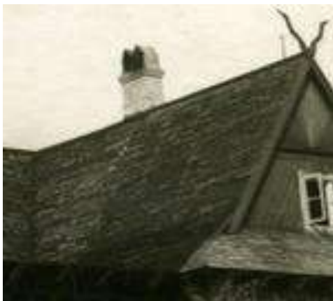
Fot . 14 Fragment fotografii z ok. 1934 r. Widok zachodniej połaci dachu i ciągłej kalenicy.
