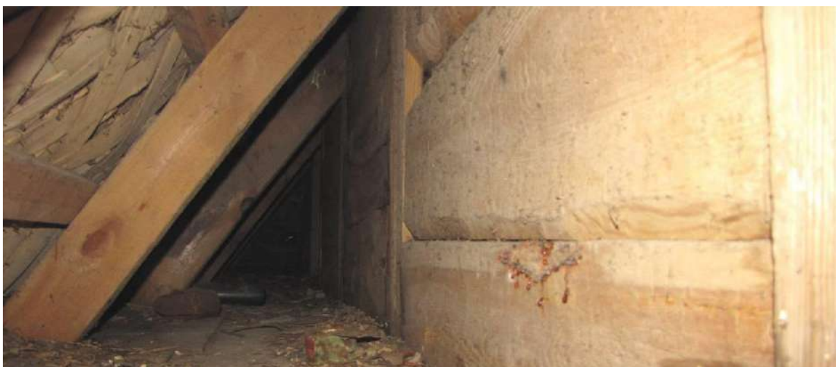
Fot. 22 Fragment ściany szczytowej w konstrukcji sumikowo-łątkowej, za połacią okapu.
