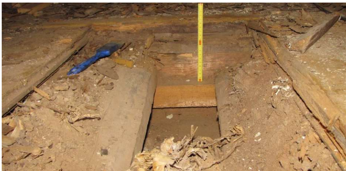
Fot. 4. Odkrywka w podłodze parteru. Warstwy stropu listwowego: deski sufitowe, opoły na łątach, glina zmieszana ze strużynami, deski podłogowe mocowane bezpośrednio na belce stropowej.
