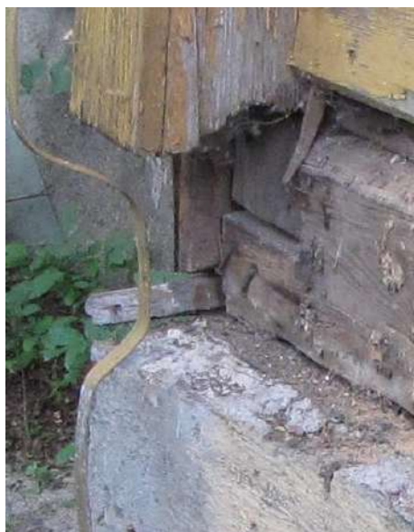
Fot. 42 Zamek ciesielski podwalin w zach. narożniku wschodniego ryzalitu.
