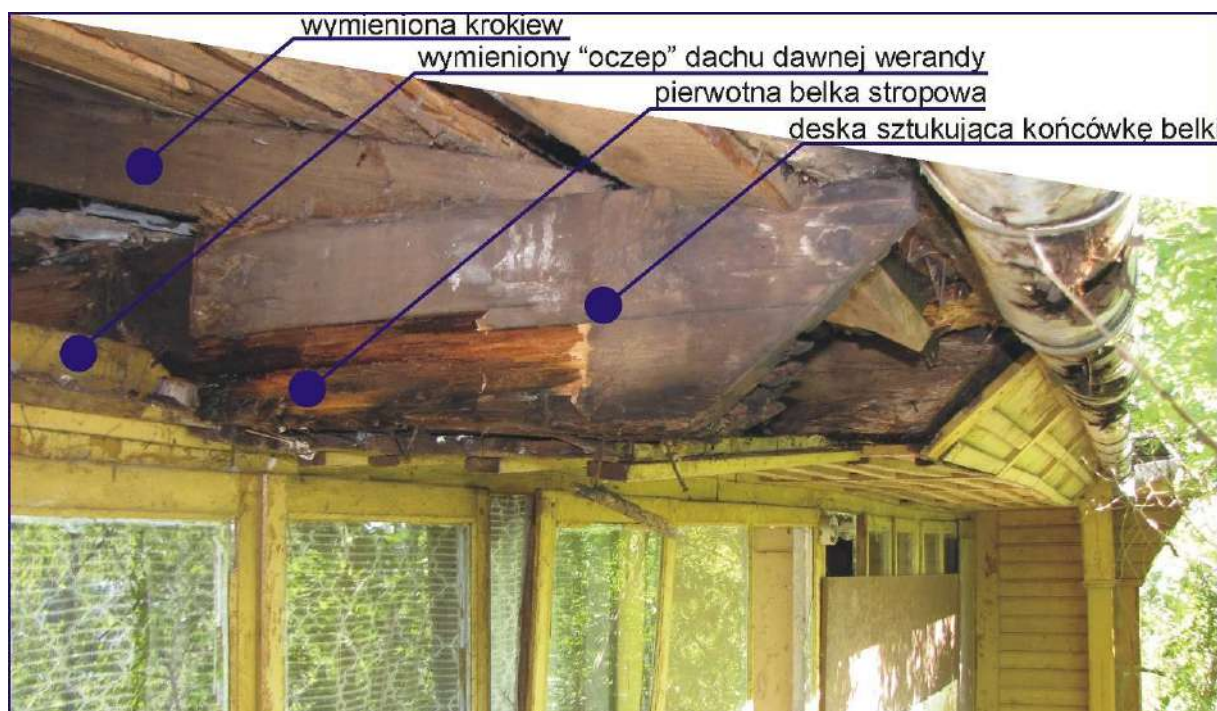
Fot. 39 Widok fragmentu konstrukcji więźby dachowej w części okapu nad wejściem głównym do budynku.
