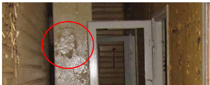
Fot . 9 Ślad po dawnym podłączeniu przewodu dymowego pieca. na wschodniej ścianie „nowego” zachodniego komina.
