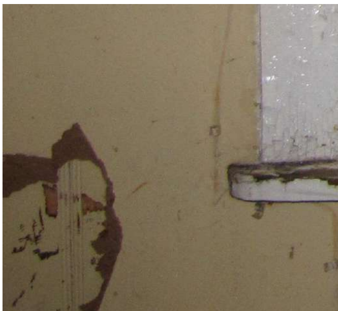
Fot. 32 Odkrywka na ścianie pokoju w zachodnim ryzalicie.
