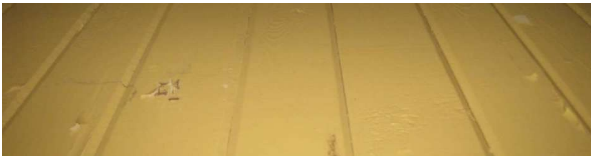
Fot. 34 Detal fragmentu ściany klatki schodowej z widocznym rysunkiem faz między deskami szalunkowymi.
