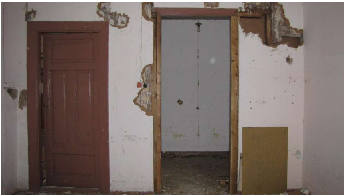
Fot . 10 Lokalizacje odkrywek w ścianie działowej d. kuchni. Widoczne, wtórne zwężenie otworu wejściowego do pomieszczenia w narożu budynku.
