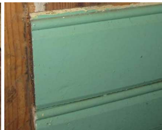
Fot. 27 Odkrywka przy oknie w ostatnim ścianie pokoju gościnnym
