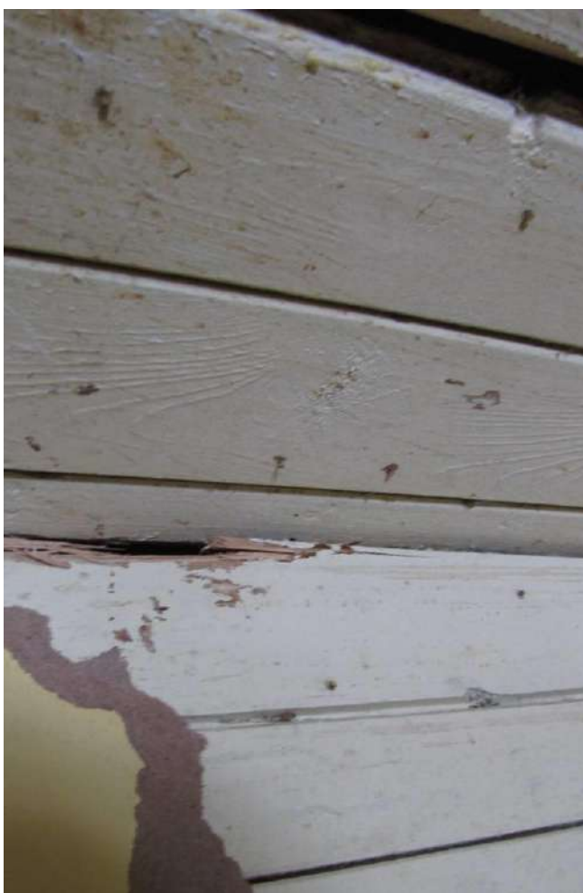
Fot. 36 Detal fragmentu ścianki działowej i pochylego stropu na poziomie poddasza.
