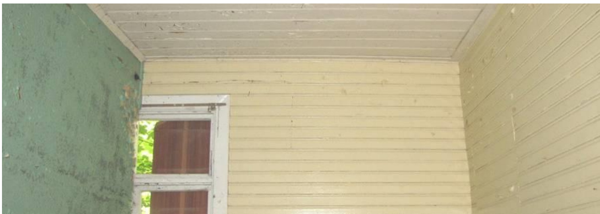
Fot. 20 Fragment skrajnego pokoiku we wschodnim narożniku budynku uwidaczniająca zróżnicowanie materiałowe wykończenia ścian. Zewnętrzne są oszalowane, działową (dzielącą również na połowę okno), wykonano z płyty wiórowej.
