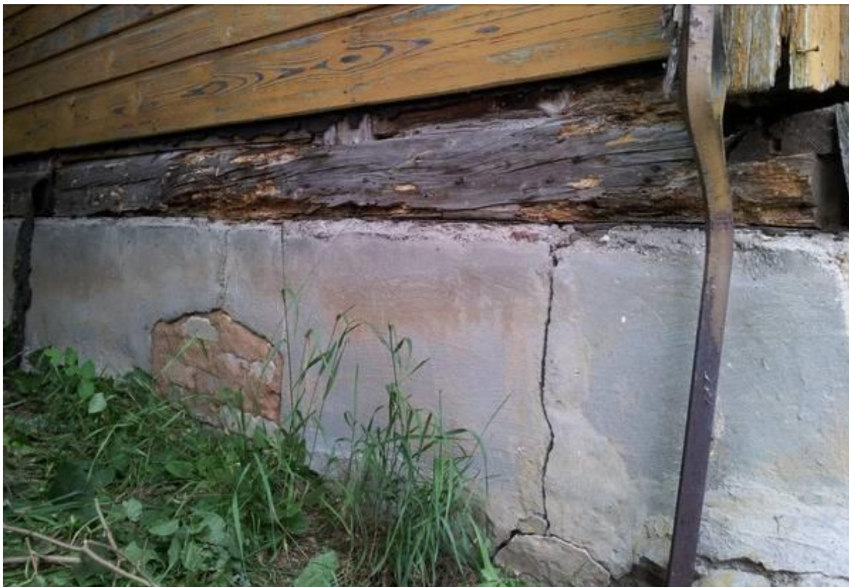
Fot. 41 Fragment fundamentu i podwaliny ściany frontowej wschodniego ryzalitu, przy południowym narożniku budynku. Widoczne również: zarysowania fundamentów i zamurowanie okna piwnicy gospodarczej.
