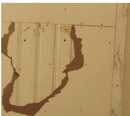
Fot. 28 Odkrywka na fragmencie ścianki działowej poddasza
