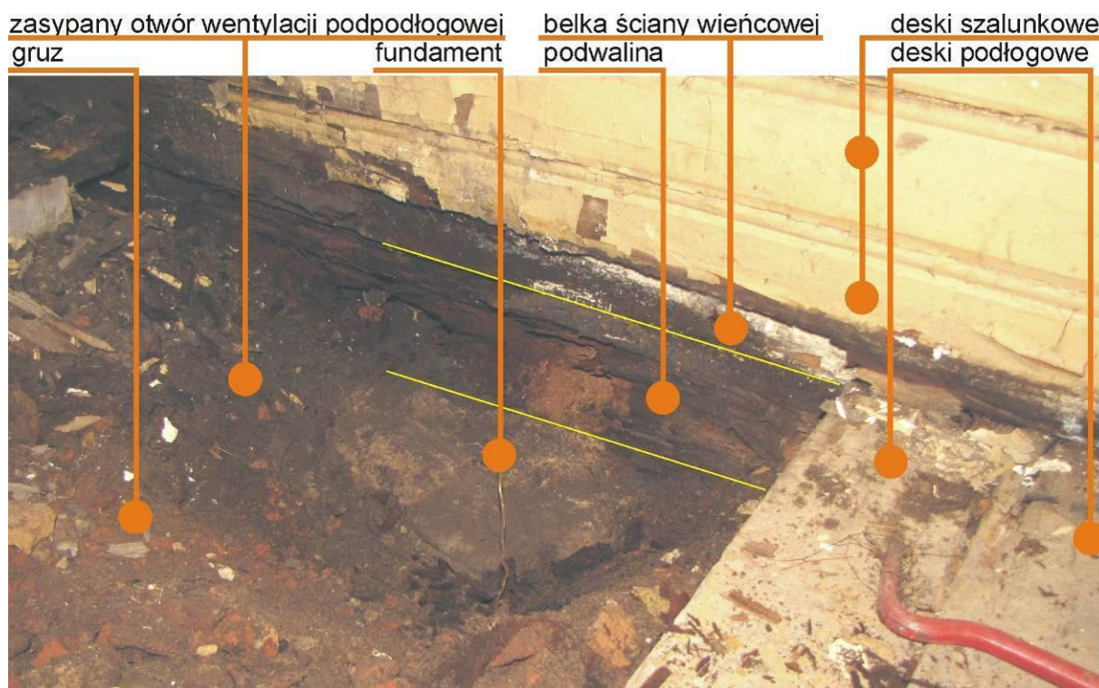
Fot. 3. Odkrywka w podłodze parteru. Detal przy ścianie konstrukcyjnej podłużnej, z widocznym fundamentem, z otworem wentylacyjnym, oraz zniszczonymi: podwaliną i belką ściany.
