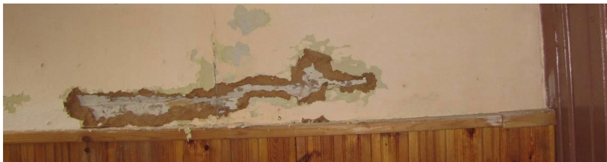
Fot. 11 Odkrywka na ścianie w przedsionku oddzielającej go od pomieszczenia narożnego, uwidaczniająca bielone, ciągłe bale sosnowe.
